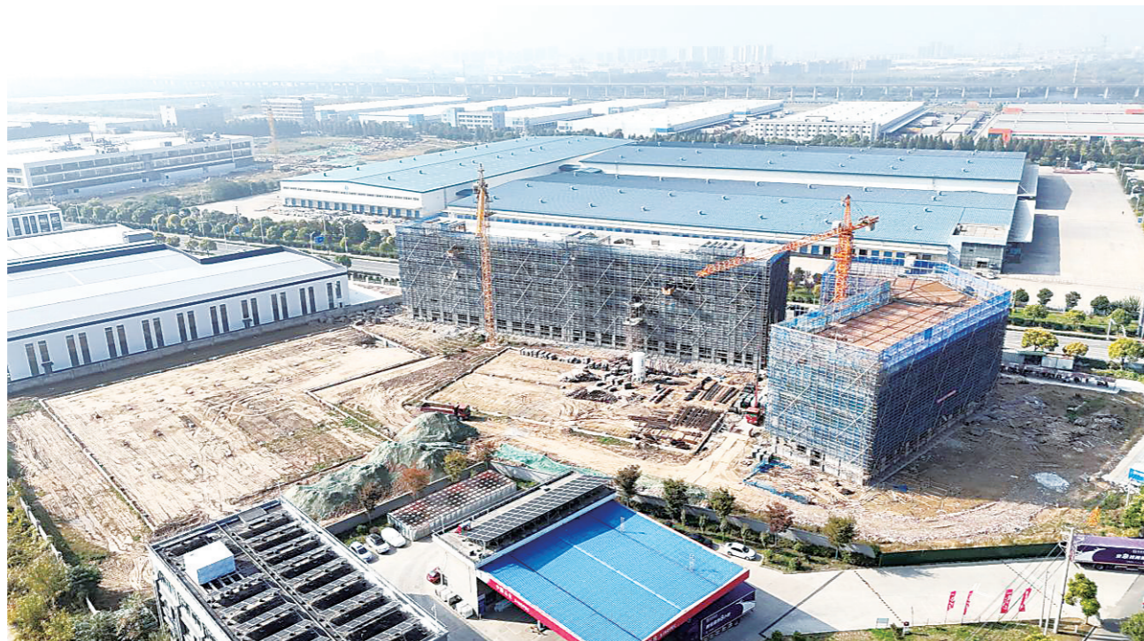
图为南马厂街道在建项目现场
