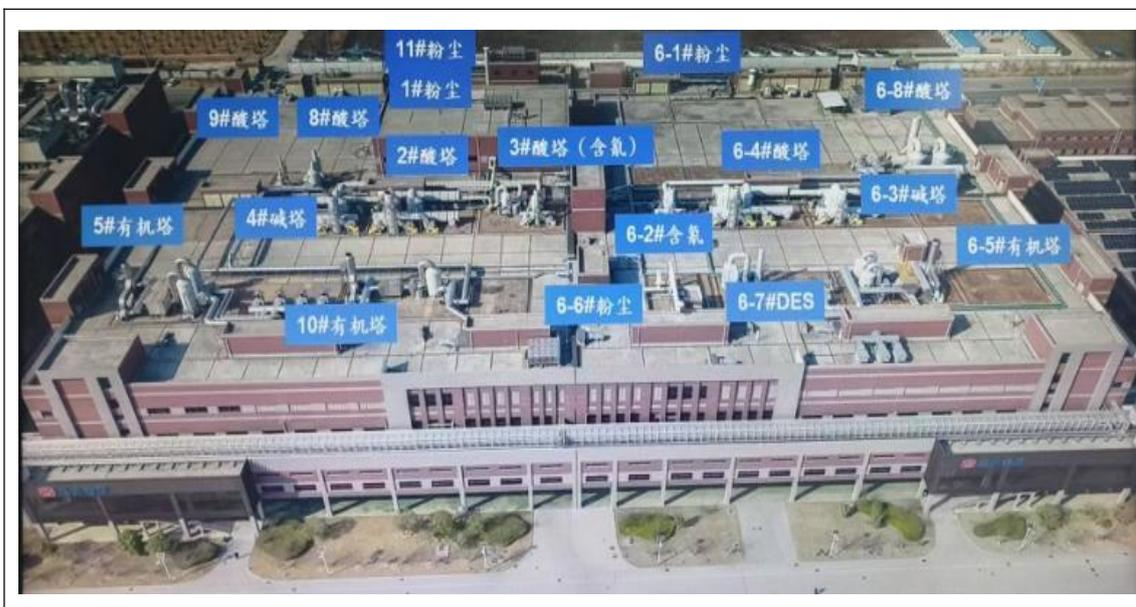
图 2-56 B05、B06 废气处理设施分布图
