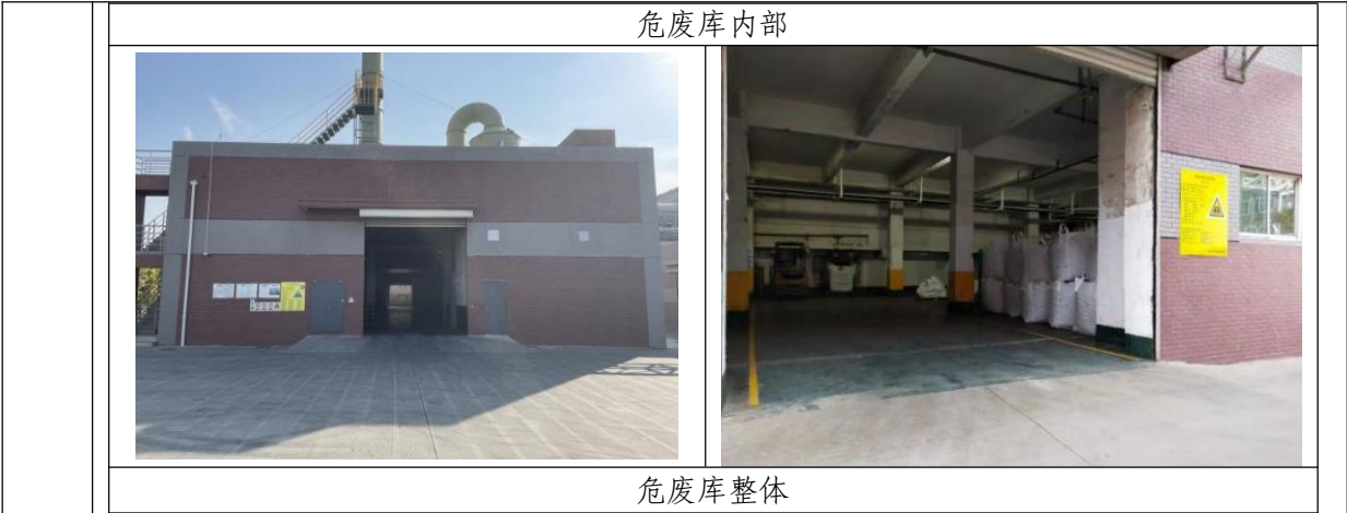
图 2-26 危废仓库设施现场图
