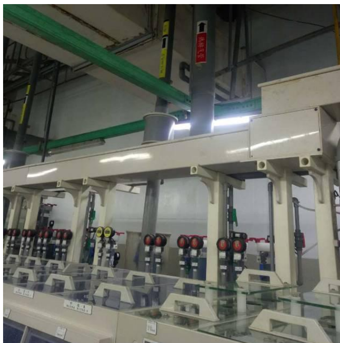
图 4-1 已建项目生产线废气收集装置示意图
